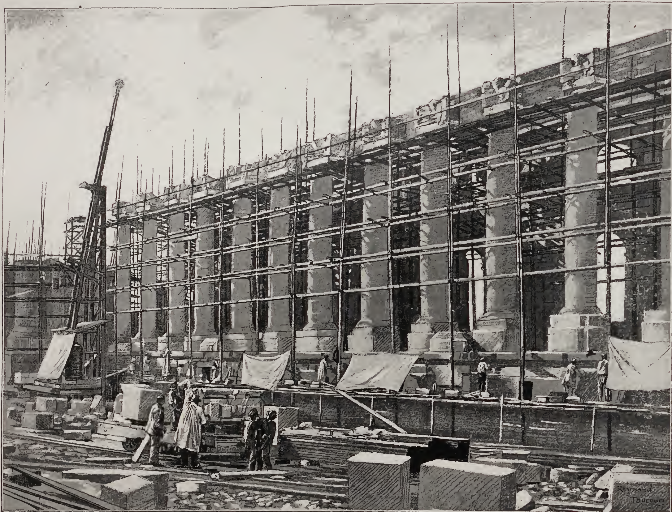
LES CHANTIERS DES CHAMPS-ÉLYSÉES. — Mise en place des chapiteaux de la colonnade du Grand Palais.
